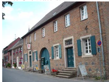
Haus des Kaufmanns Moritz Daniels, gebaut 1714, heute Touristikzentrale
