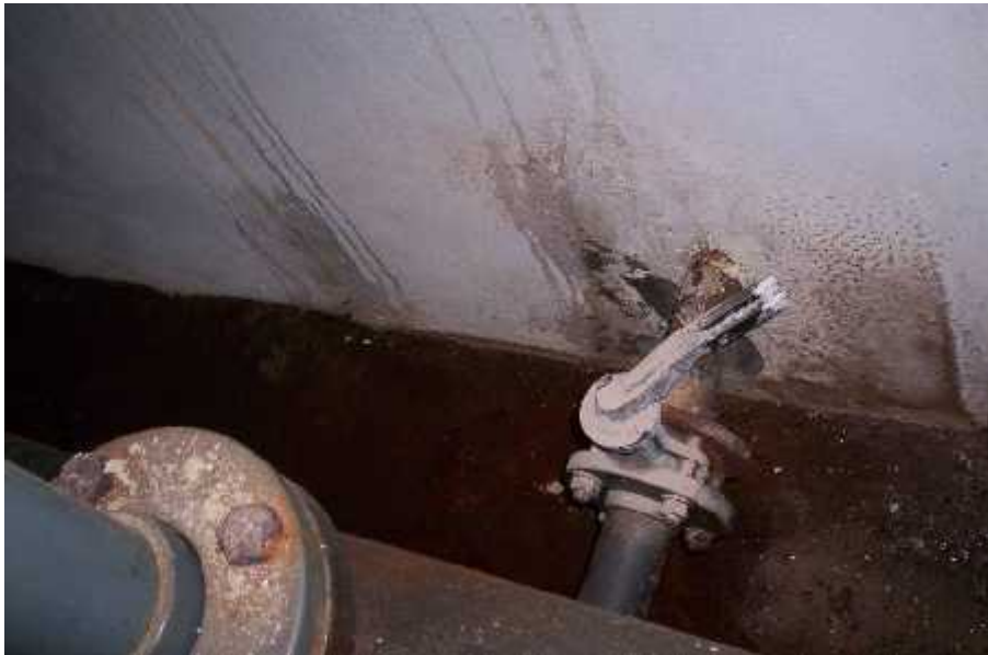
Bild 22: Wasser im Beckenumlaufgang
