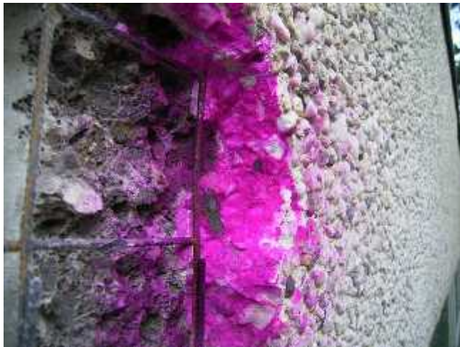
Bild B20: Prüfstelle 3 - Außenfassade
