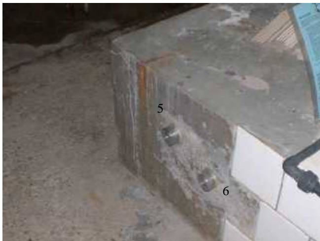
Bild B3: Kellergeschoss - Prüfstellen für die Messung der Haftzugfestigkeiten
