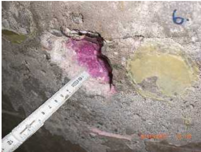
Bild B18: Prüfstelle 1 – Fundament 1
