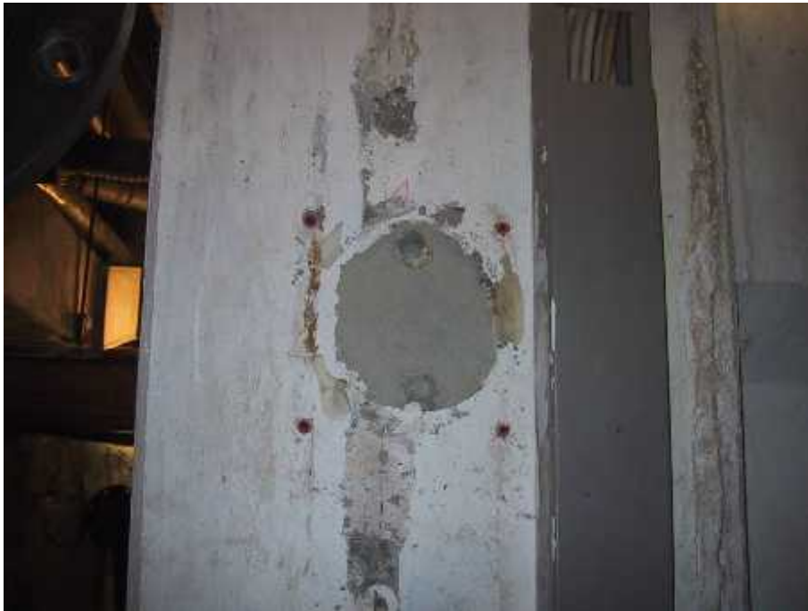
Bild A5: Beispiel für den 2005 erneuerten Verguss der Spannankerköpfe
