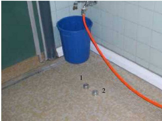
Bild B1: Erdgeschoss - Prüfstellen für die Messung der Haftzugfestigkeiten
