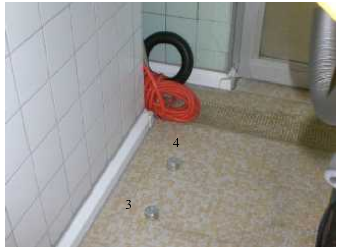
Bild B 2: Erdgeschoss - Prüfstellen für die Messung der Haftzugfestigkeiten
