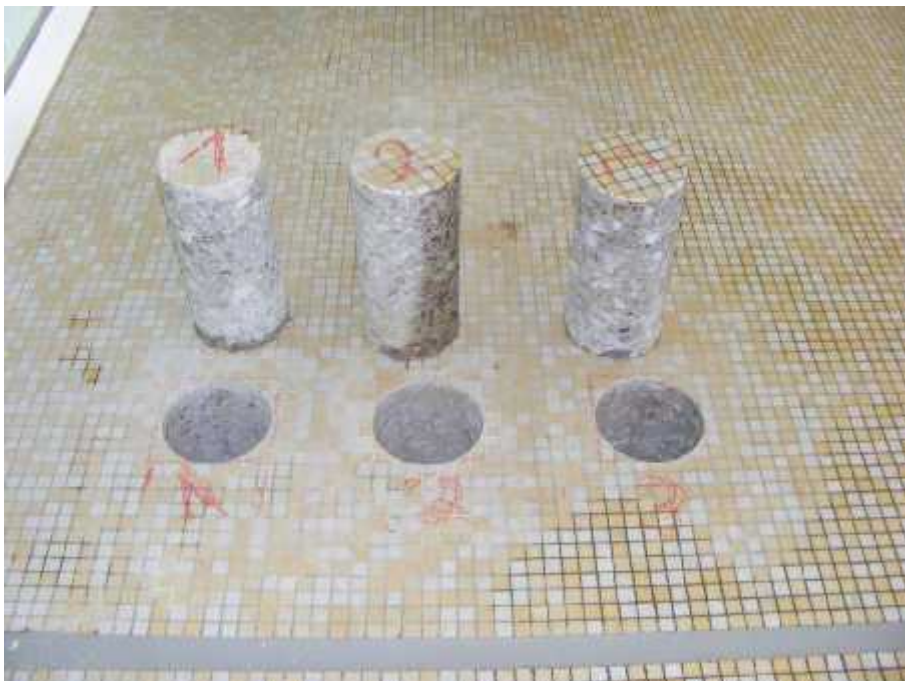
Bild A4: Bohrkernentnahme im Aufsichtsräum des Schwimmmeisters
