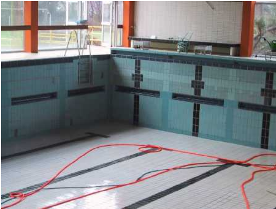
Bild A1: Blick in das Becken nach der ersten Instandsetzungsmaßnahme 2005
