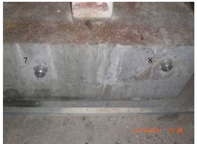
Bild B4: Kellergeschoss - Prüfstellen für die Messung der Haftzugfestigkeiten
