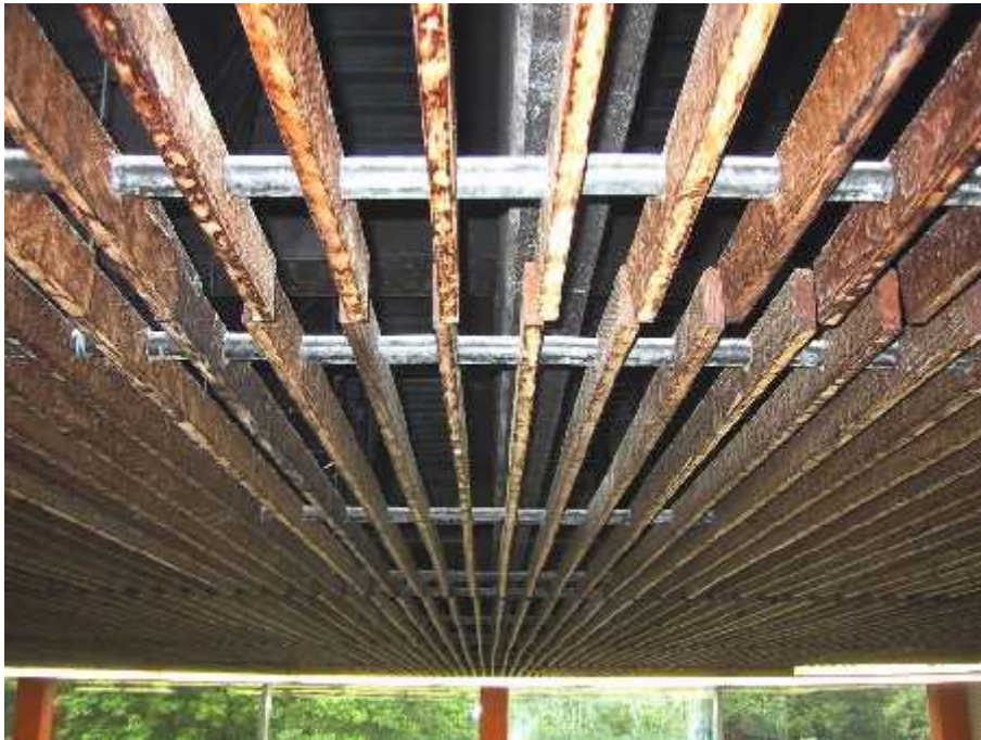
Bild 6: Blick auf die Unterdecke aus einzelnen Holzbrettern
