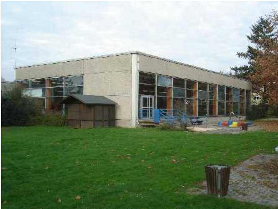
Bild 16: Glasfassade der Schwimmhalle mit einzelnen Scheiben, die Kondensat im Scheibenzwischenraum aufweisen
