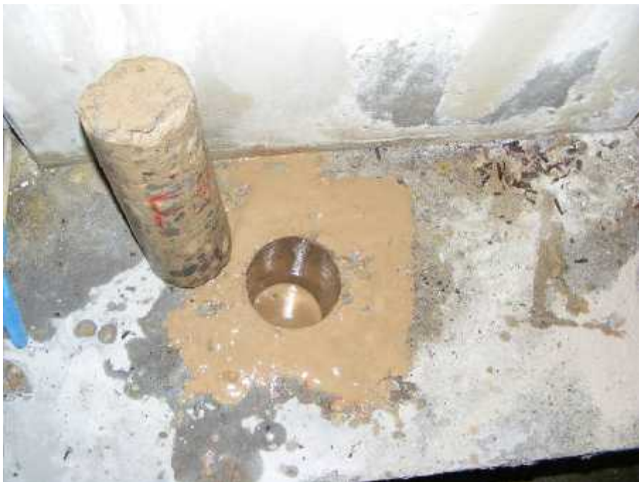
Bild A3: Bohrkernentnahmestellen im Bereich des Fundamentes für den Kern F3
