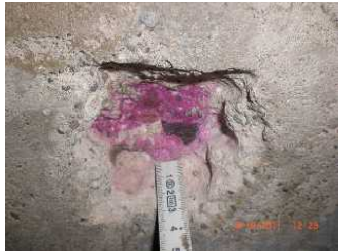
Bild B19: Prüfstelle 2 – Fundament 2
